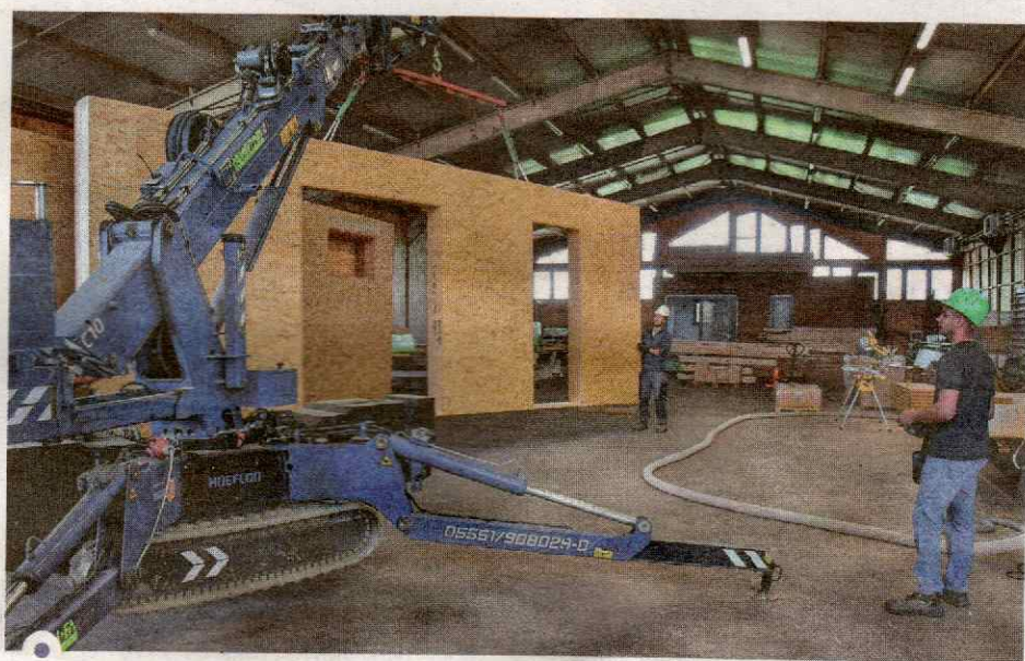
MODERN GÉPEK SEGÍTSÉGÉVEL MOZGATJÁK A FAHÁZAK PANELJEIT A GYÁRTÓCSARNOKBAN.
